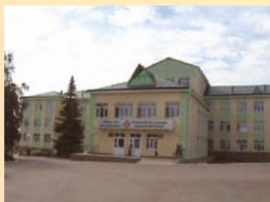
Здание райбольницы после реконструкции
